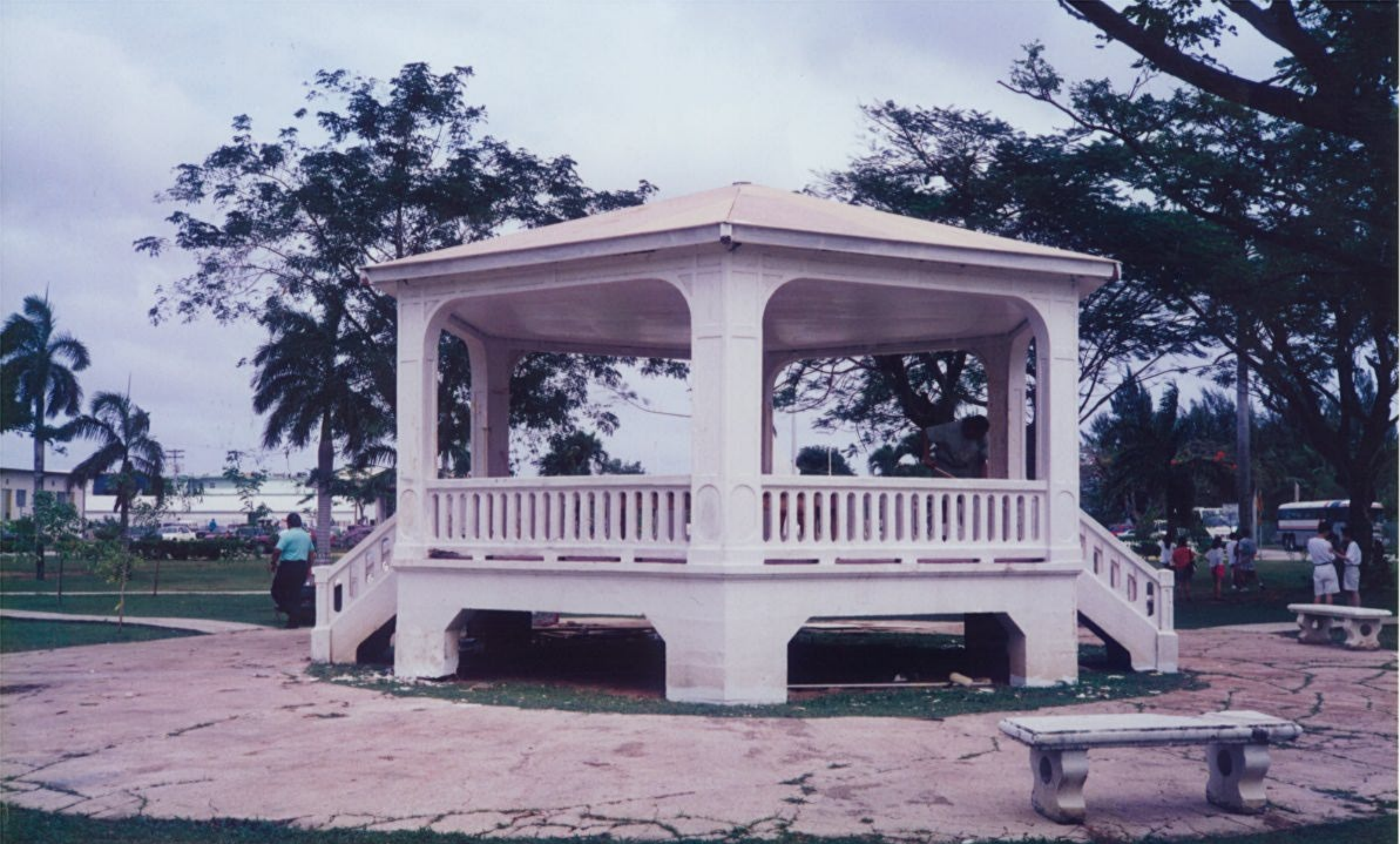
12. KIOSKO W/PLYWD. ROOF FOR INAUGURATION
